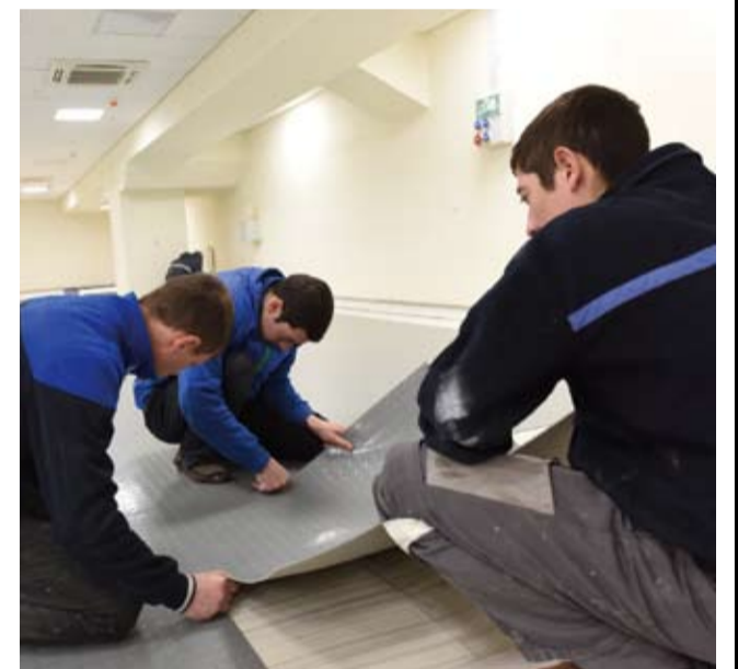
На фото: готовые помещения сектора «А»; завершающие строительные работы.
