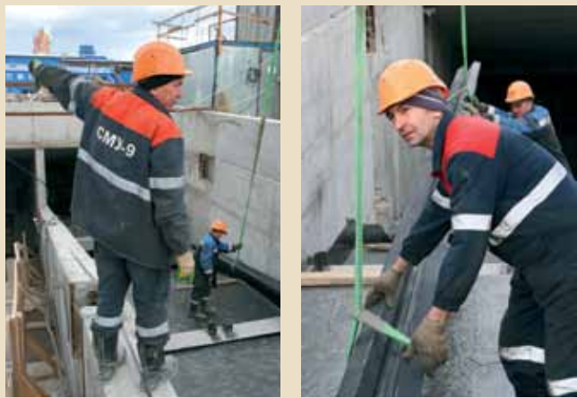
На фундамент устанавливаются первые прогоны траволаторов. Командует – «Девятка»!
