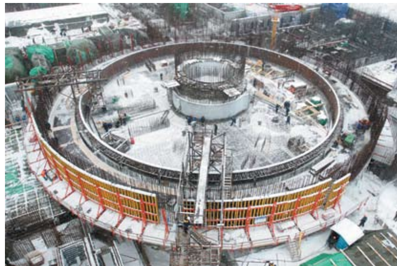
1-й ядерный реактор. Стройка в разгаре
